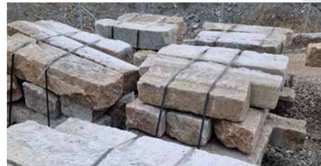
Stenen tvättas, sorteras och lagras i väntan på att användas på nytt i nya projekt.
